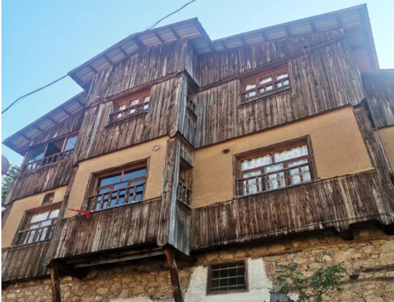
Şekil 16. İlhami Örnekçi evi cephe görseli Zemin kat, 1. kat ve 2. kat olmak üzere 3 kattan oluşan yapı meyilli araziye
