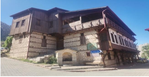
Şekil 4. Ali Fuat güven evi cephe görseli Bodrum+ zemin+ çatı katı (Dam Yetme) olmak üzere 3 katlıdır. Zemin katı moloz taş duvarlı, ahşap hatıllı olup zemin katın ana caddeye bakan 1. katın cephesi ve yan
